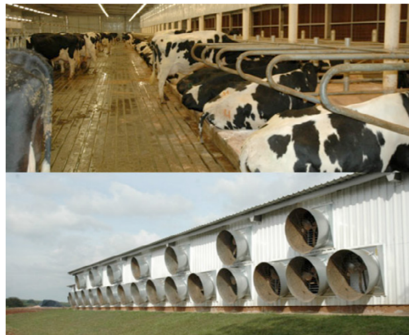
Figura 2. Sistema de ventilação cruzada e temperatura e luminosidade controladas da fazenda Colorado no interior de São Paulo
