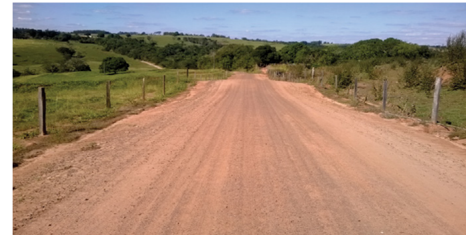
Figura 26. Estrada rural após serviço de adequação.
