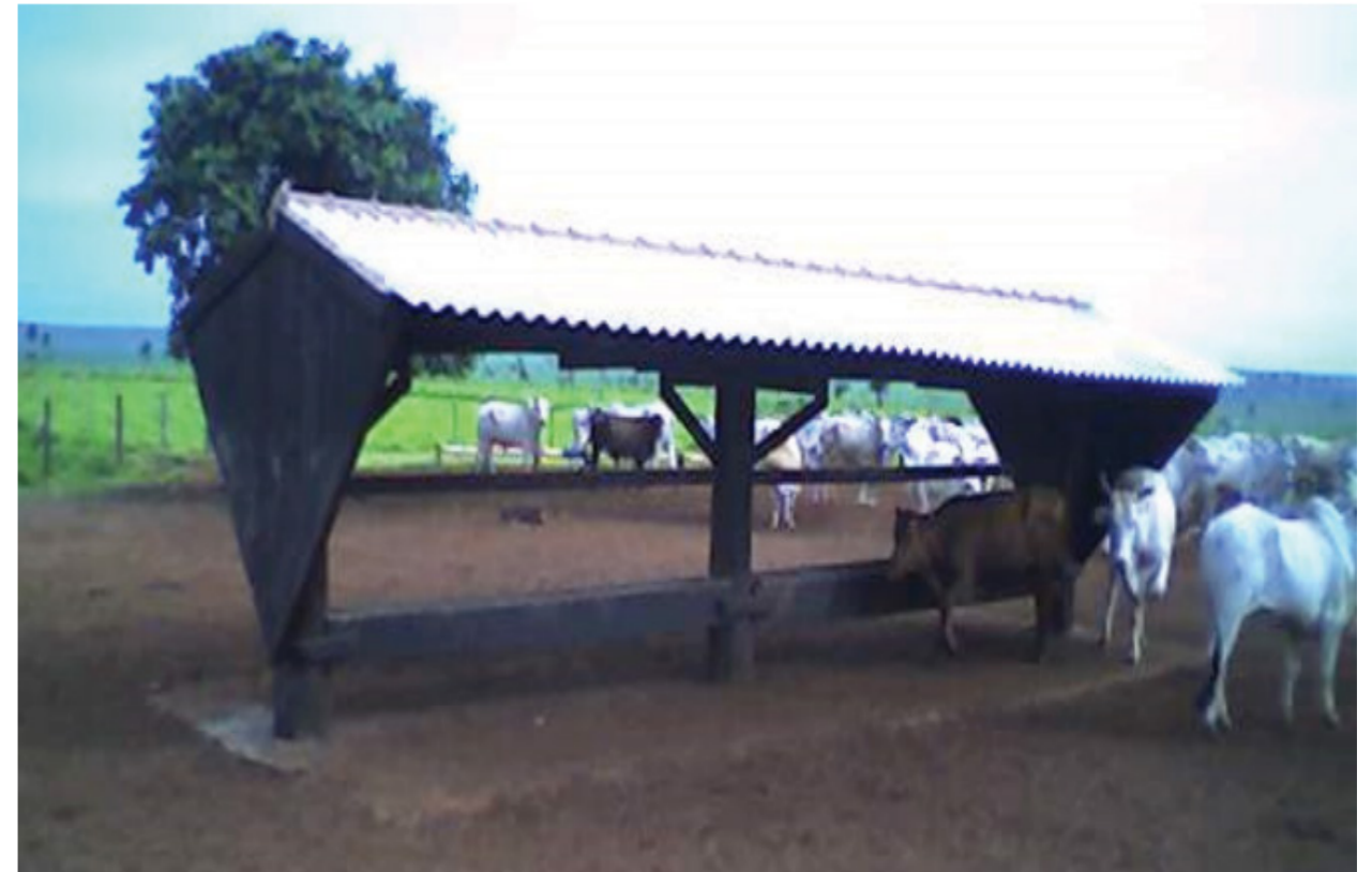
Figura 29. Cocho coberto, com piso concretado e depósito de sal na parte inferior da cobertura.
